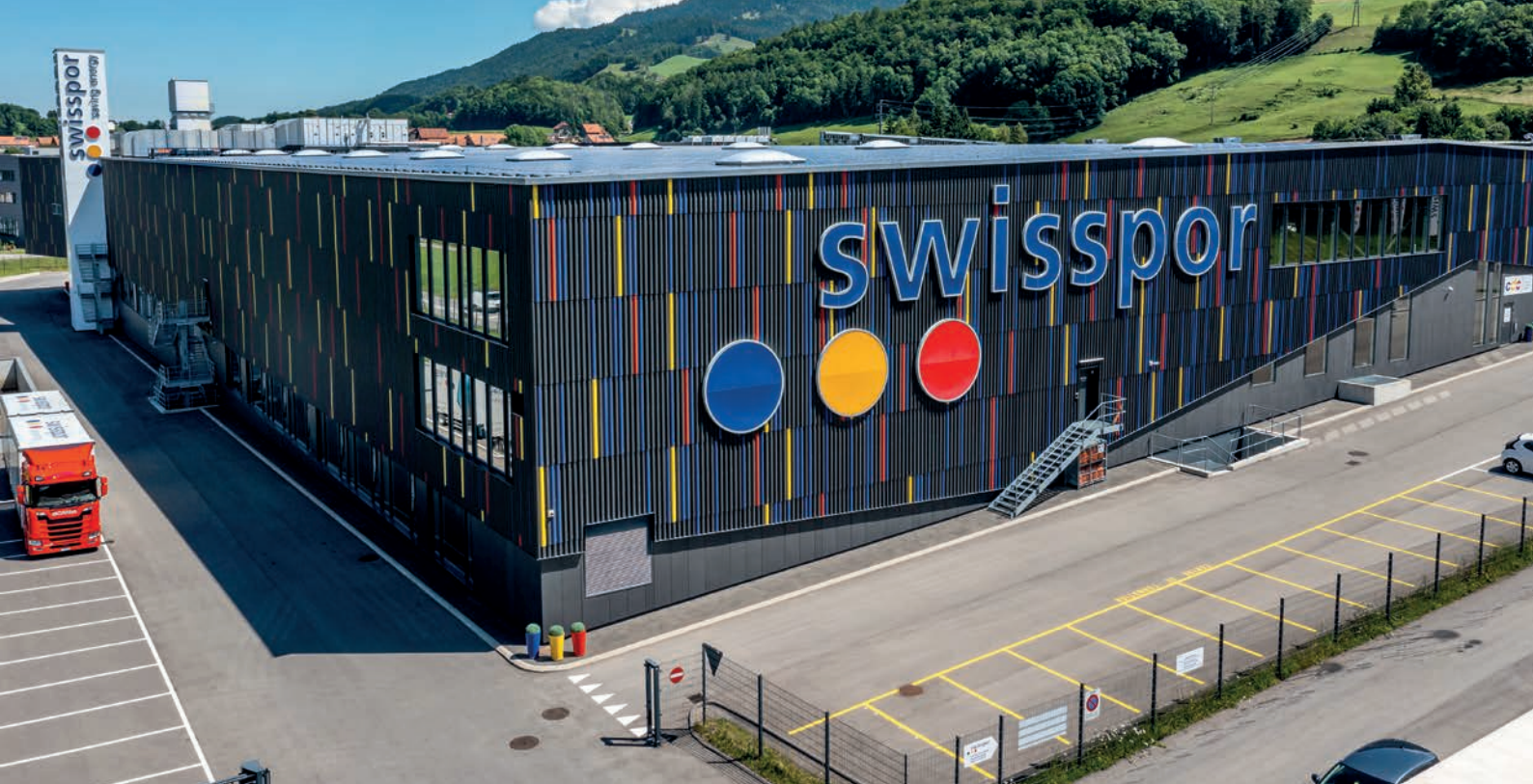
Centre de compétences (CDC) de swisspor Romandie SA à Châtel-St-Denis.
