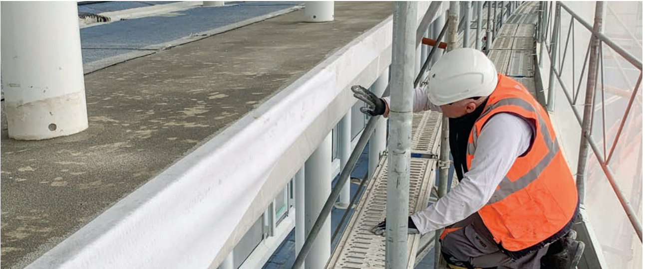
Entoilage de la tête de dalle avec un voile de renfort dans la résine liquide.
